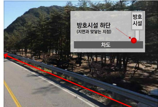
차량방호안전시설만 설치된 경우
