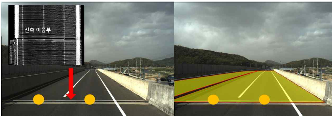
(a) 교량 신축 이음부
